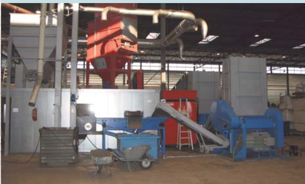
Nieuwe shredderinstallatie voor zware kabel met afzuiginstallaties, zeven en windsifters.
